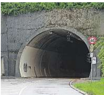
Der Tunnel Bad Abbach ist erst Ende Januar wieder nutzbar.
