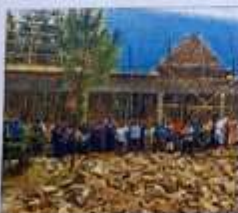
Schulbau Kaiza: Fotos von Baufortschritt in Kanyigo trafen oftmals täglich ein.
